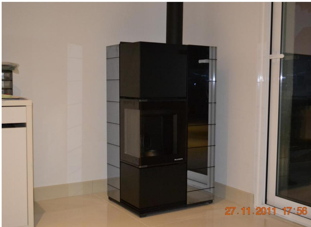
*Chauffage principal maison 80 m<sup>2</sup> avec un poêle granulés Palazzetti. Création conduit Fumées concentrique sur sortie toit terrasse.*
