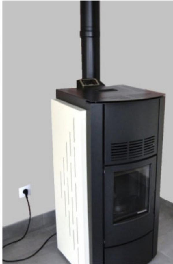
*Poêle à Pellets de marque Palazzetti dans une maison type BBC de 80 m<sup>2</sup>. Sortie de toit zone 2 suivant réglementation.*
